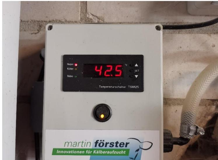
**Grafik 27: Steuerungseinheit ( nachher) mit elektronischer Anzeige**
